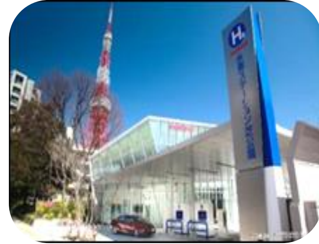
水素ステーション
