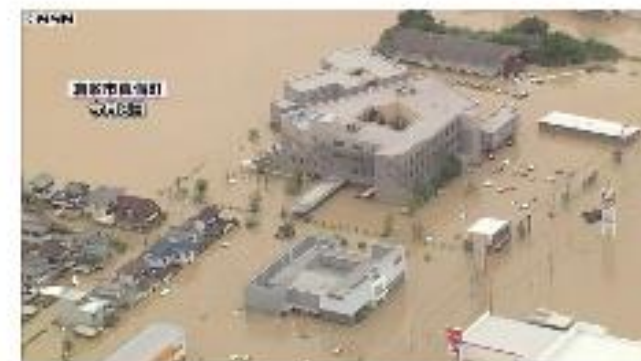
倉敷市真備町河川氾濫
