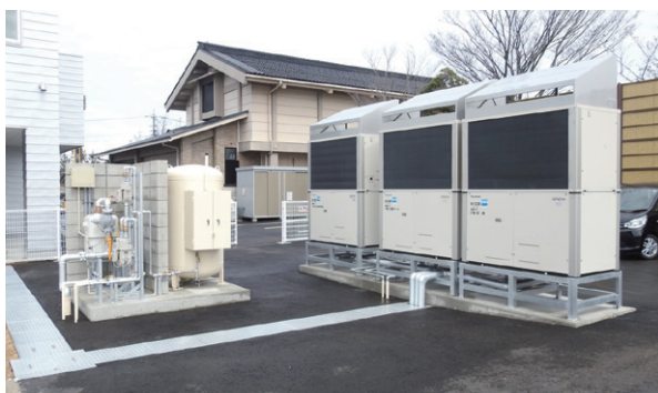
電源自立型GHPと災害対応バルク
