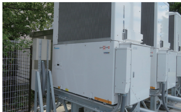
室外機をかさ上げ設置（出羽小学校）
