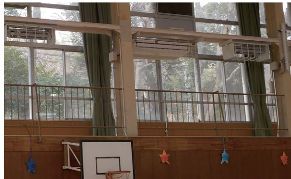
高野小学校体育館
