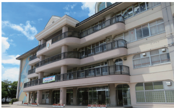
GHP3台を設置した出羽小学校
