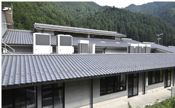
屋上に電源自立型GHPを設置した
