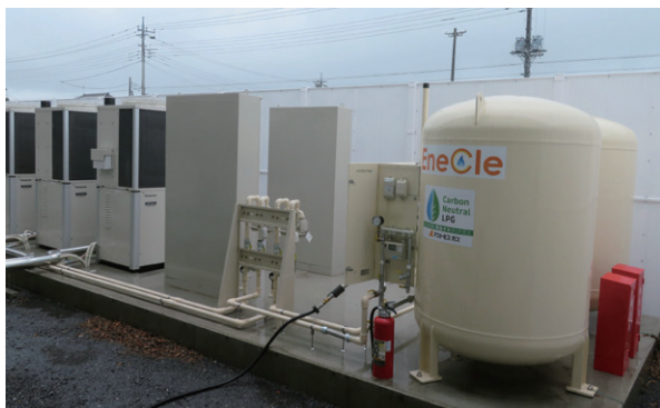
電源自立型GHPと災害対応バルク（明和中学校）
