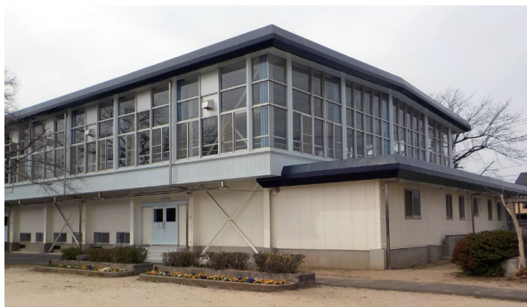
大野小学校体育館外観
